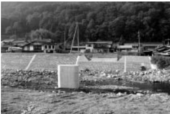
上部橋梁工事が行われる中村橋
