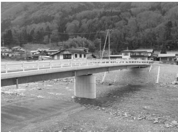
災害復旧工事が完了した中村橋
