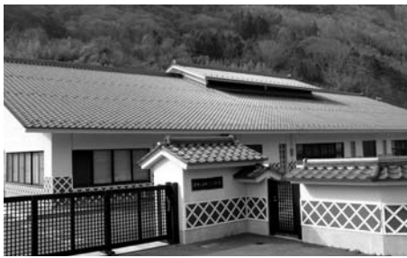
和田地区下水処理場 (クリーンハート和田)
