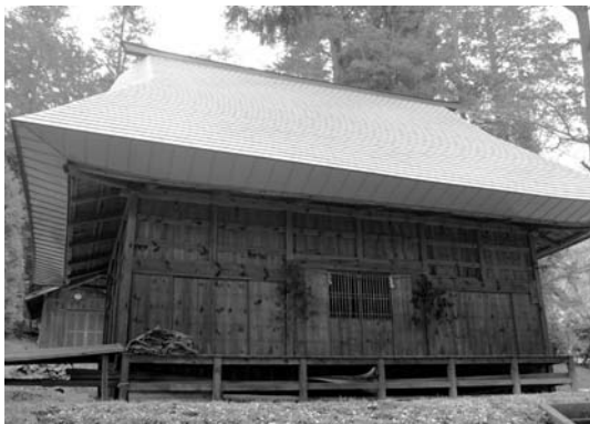
屋根改修が終わった町指定文化財の和田神社
