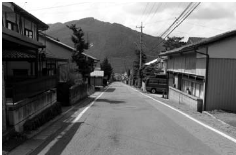
舗装整備が実施される長久保野町地区
