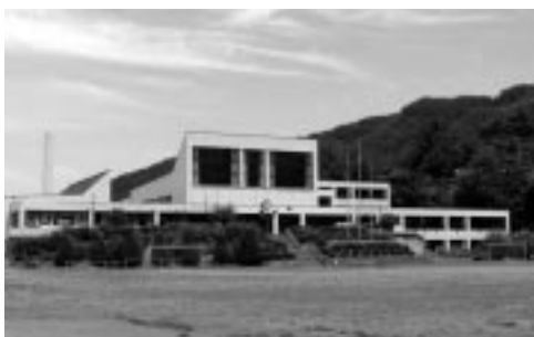
屋根の改修工事を行う長門小学校
