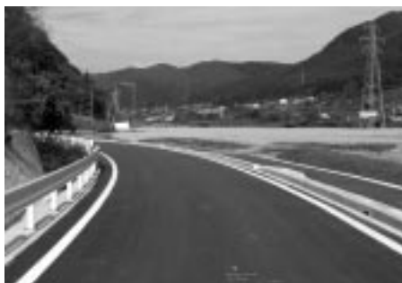
建設が進む長久保青原線
