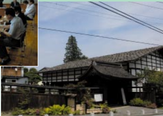
屋根の改修が終わった和田宿本陣
