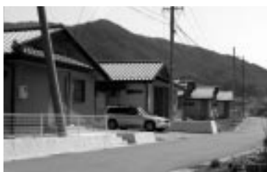
宮下住宅団地に建設された町営住宅
