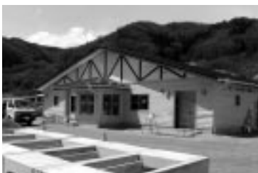
現在、建築中のダツタンソバ加工施設
