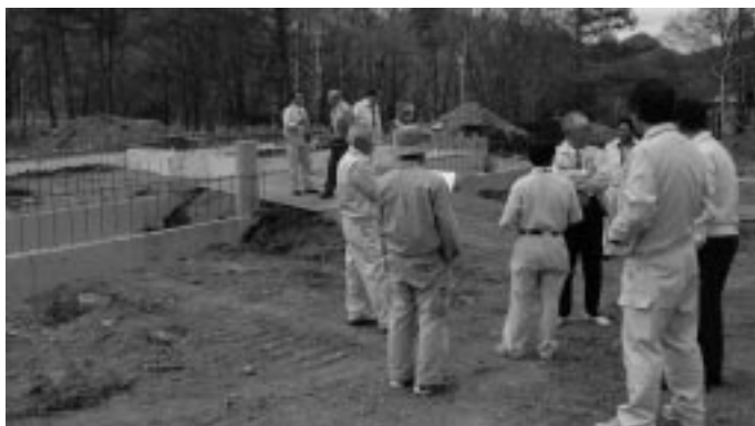
建築中の姫木コミュニティセンター
