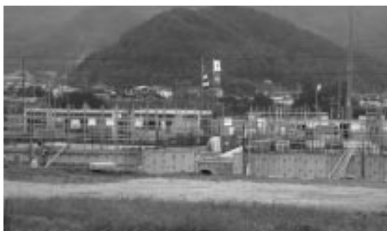
建設中の町営マンション
