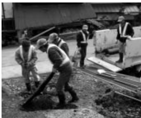
町営住宅入口の補修作業を行うサポート係
