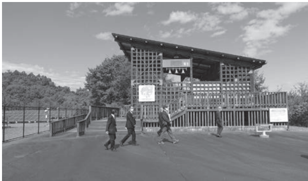
飯田市「おひさま発電所」を視察
