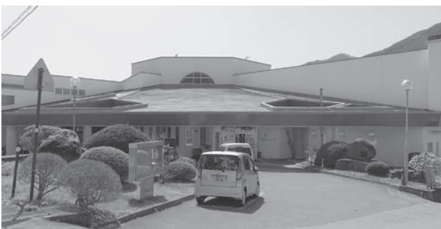
補修改修が続く公共施設（長門老人福祉センター）
