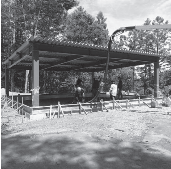
学者村山の家広場東屋建設工事
