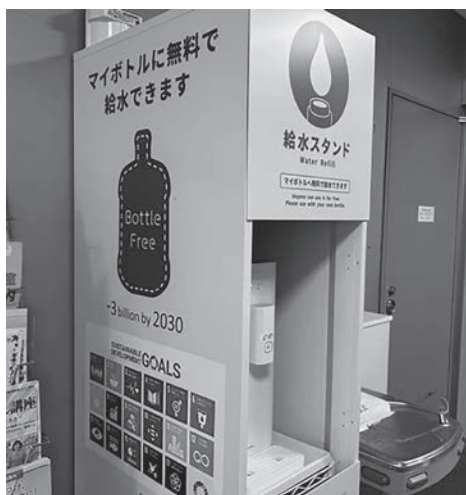
飲料水の給水スタンド
