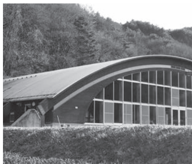
湯遊パーク屋内ゲートボール場
