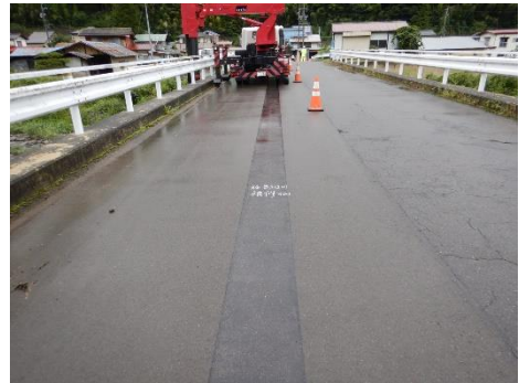
写真 2. 縦目地補修例 三開戸橋 (伸縮装置補修)
