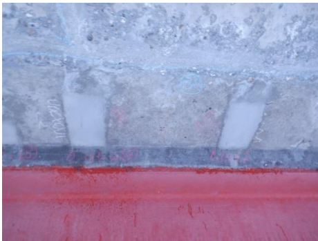
写真 3. 床版補修例 大多沢橋 (断面修復工)
