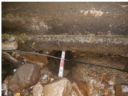
健全度 III : 三ノ又橋
