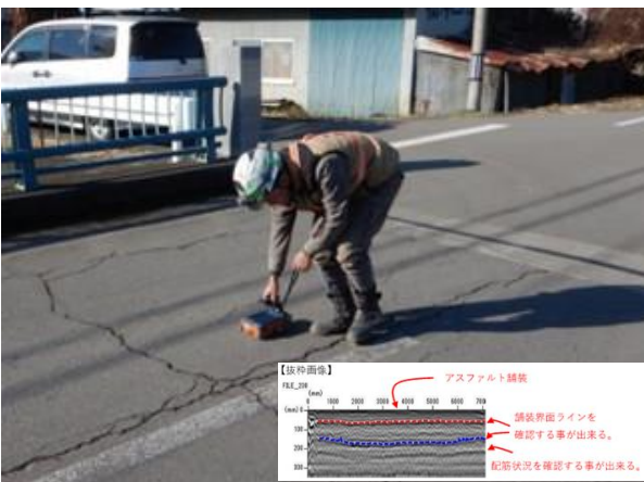
電磁波レーダ法による床版調査
