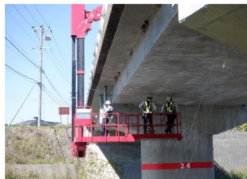
橋梁点検車による点検
