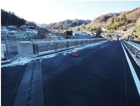
写真 1. 舗装補修例 大門橋 (舗装打換え)
