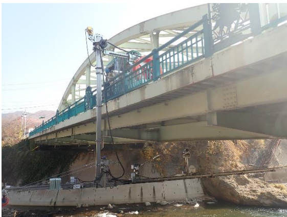
橋梁点検支援用ロボット
