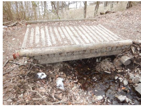
写真 4. 架替え例 歴史の道 1 号橋
