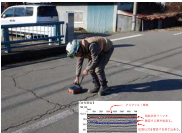
電磁波レーダ法による床版調査
